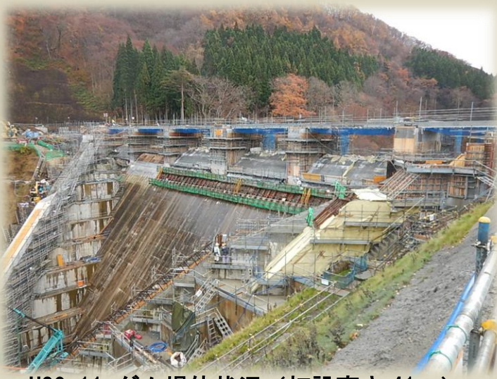
H30. 11 ダム堤体状況（打設高さ41m）
