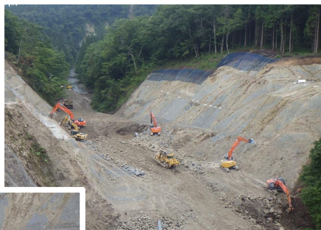
基礎掘削工事状況
