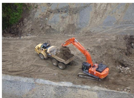
重ダンプトラックによる残土運搬
