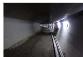
トンネル内の通路
