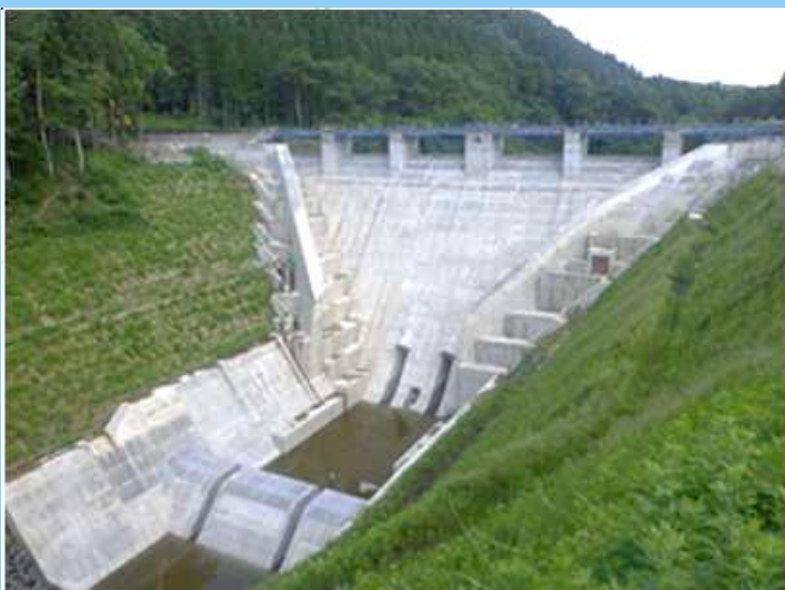
R1.10 ダム工事状況 (高さ41m)
