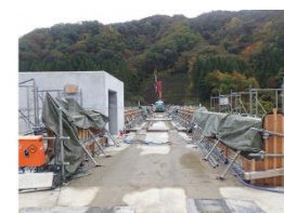
ダム天端(地覆高欄コンクリート打設)
