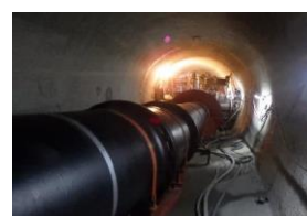
ダム付近(排水路トンネル内維持放流管)作業箇所
