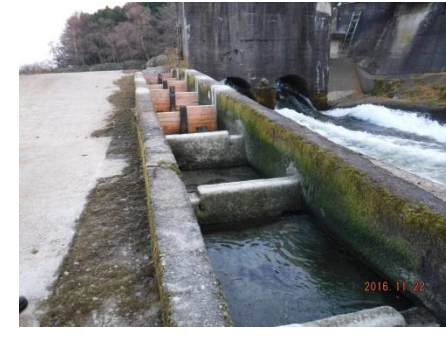
7 魚道の改修 瀬見発電所 頭首工 最上町 大堀
