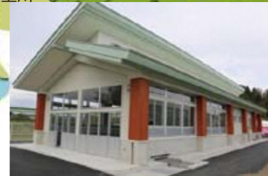
アユ中間施設育成とサケふ化場の 併用施設（舟形町舟形）
