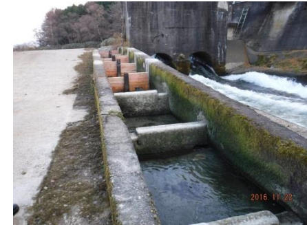
⑦ 魚道の改修 瀬見発電所 頭首工 最上町 大堀
